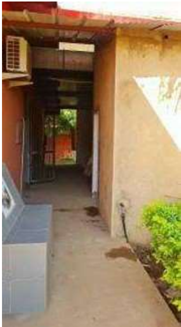
Accesso al nuovo ambulatorio dal lato dell'officina farmaceutica
