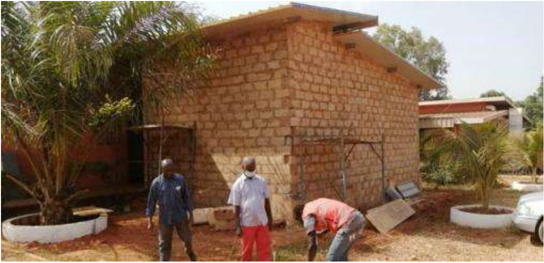
12 gennaio 2021 Ampliamento della palazzina tecnica dell'officina farmaceutica
